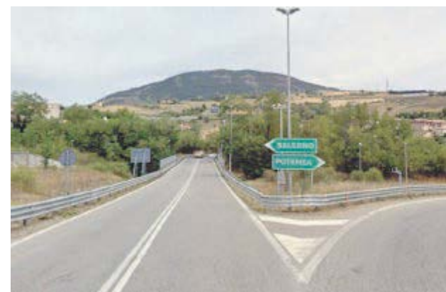
Torna alla normalità la circolazione dopo i lavori di ammodernamento del viadotto
